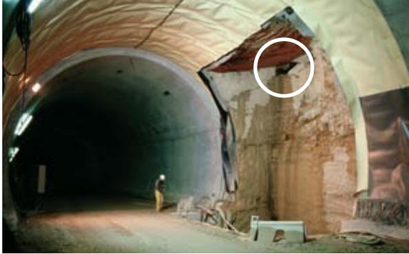
Höhle (im Kreis), die beim Vortrieb eines Tunnels der Autobahn A5, Neuenburg – Yverdon angeschnitten wurde. Bei Hochwasser strömt mehr als 1 Kubikmeter Wasser pro Sekunde aus diesem Gang!
