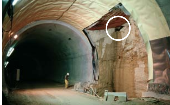
Cavité (dans le cercle) recoupée lors du percement d'un tunnel sur l'autoroute A5 Neuchâtel-Yverdon. En période de crue, plus d'un mètre cube d'eau jaillit par seconde de ce conduit!
