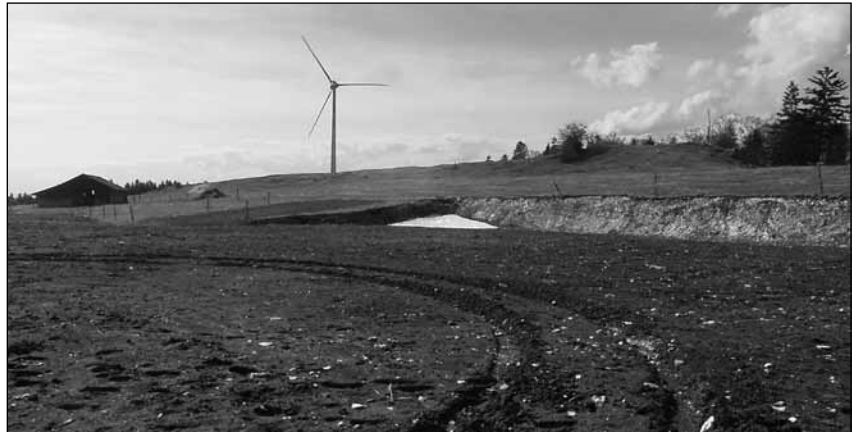
Erstellen einer Windmühle im Karstgebiet (St. Brais, JU, photo P. Meury).
