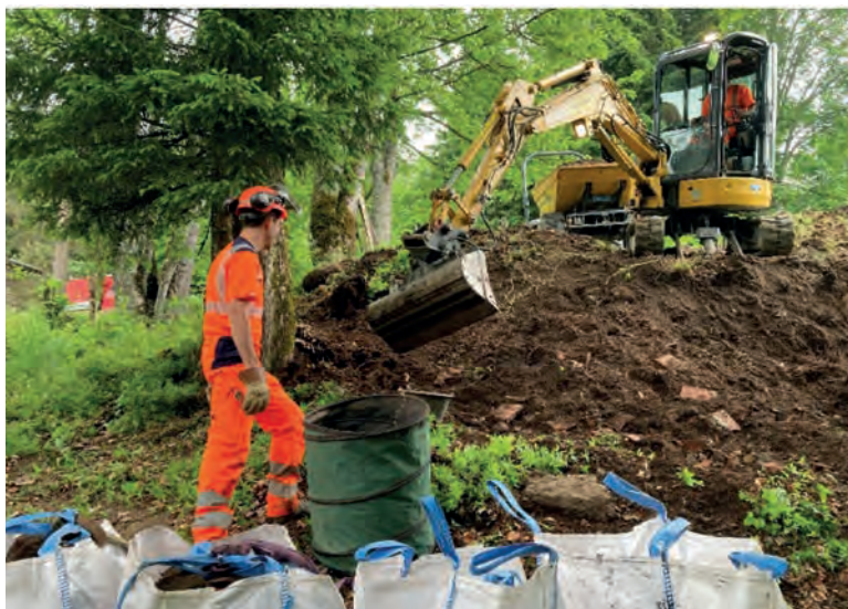
Certaines interventions nécessitent des moyens mécaniques. Le déchets sont triés par type et évacués vers les filières adaptées. Un exemple de doline assainie sur la commune d'Ollon (VD).
